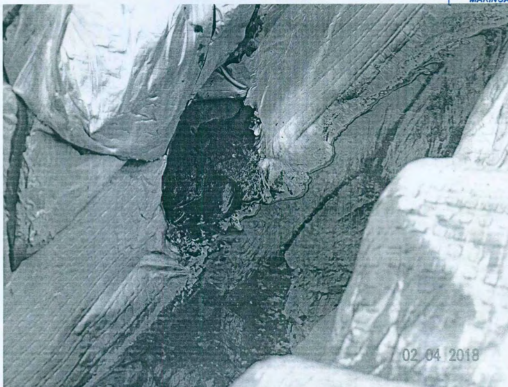
Figura 6 – Boca do ralo 1 com sujeira e não impermeabilizada.
