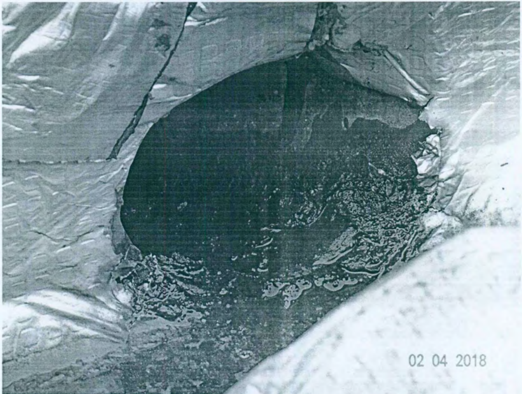
Figura 7 - Detalhe da entrada do ralo 1. Sujeira e deficiência na impermeabilização.
