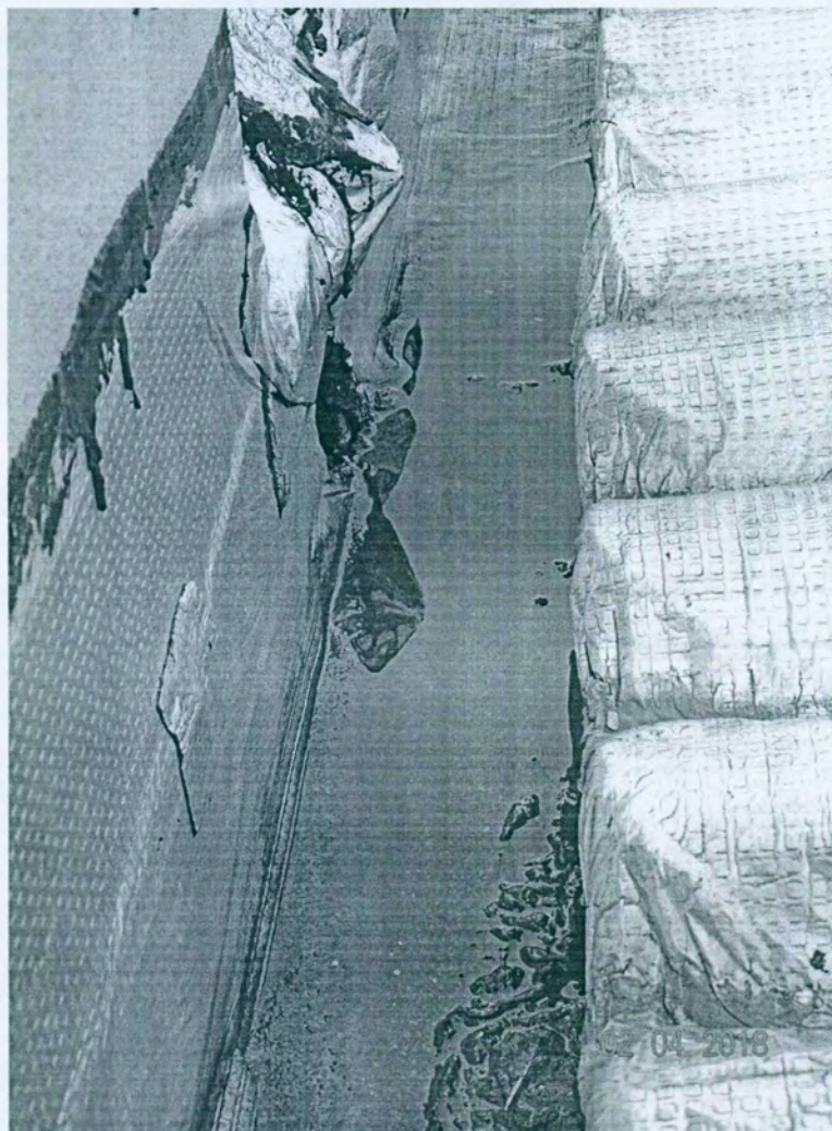
Figura 8 – Ralo 1: sujeira e água empocada na calha devido à declividade inadequada
