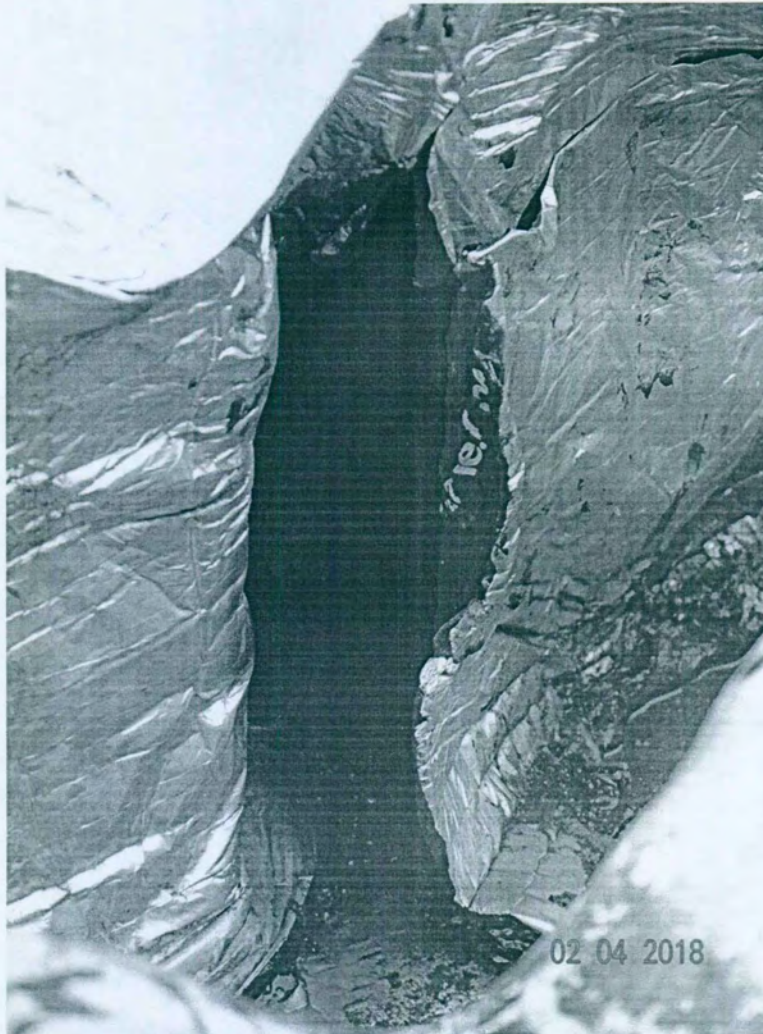
Figura 10 - Detalhe do buraco existente na manta.
