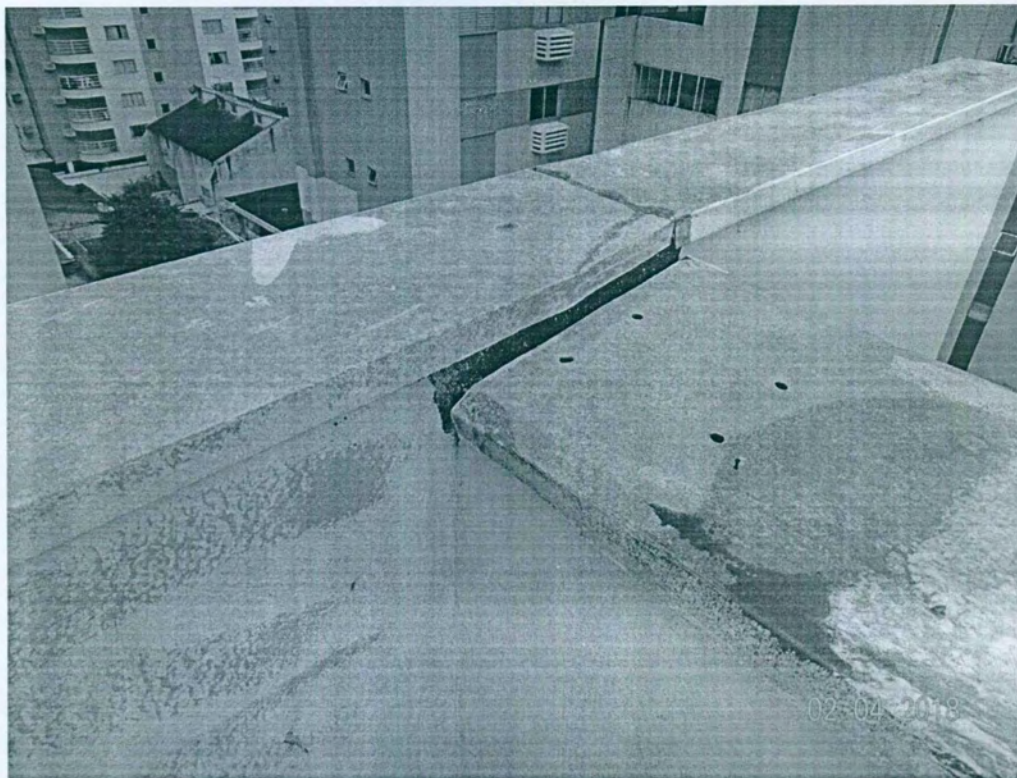
Figura 16 - Rufo desafixado e sem vedação, permitindo a entrada de água.
