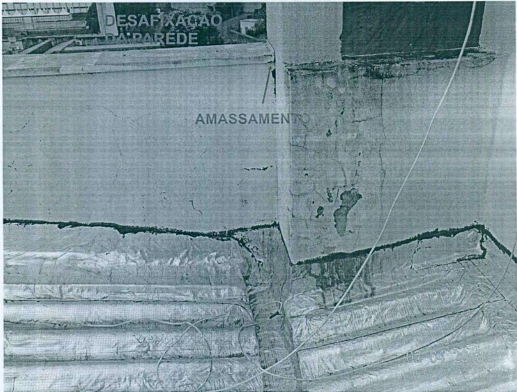
Figura 14 - Amassamento e desafixação do rufo.
