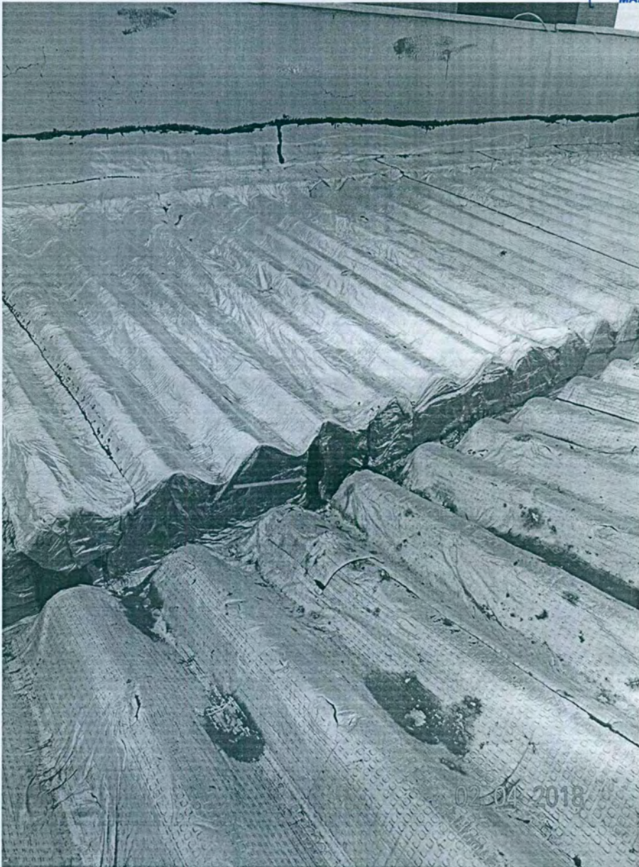
Figura 9 - Localização do buraco presente na manta de impermeabilização
