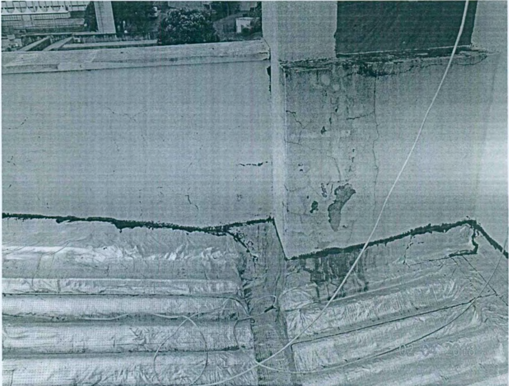
Figura 19 - Pintura da platibanda desgastada e com sinais de infiltração de água.
